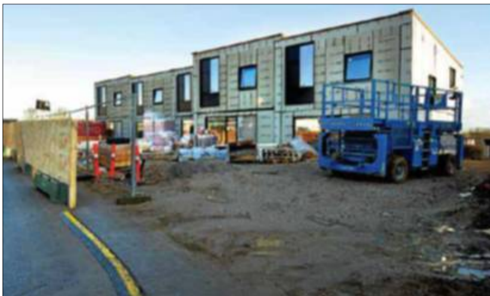
Der er stadig fuld gang i byggeriet af Drabæk Huse. Indtil videre er kun 15 boliger blevet overleveret. Flere følger om cirka tre måneder.
